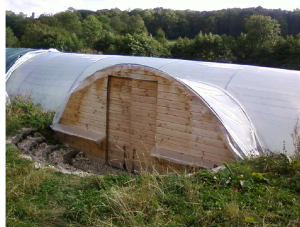
L'un des quatre bassins, 20 cm de profondeur. L'entrée de l'espace technique au centre de la serre.
