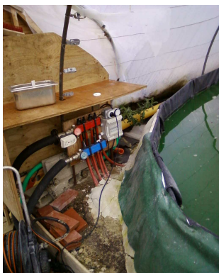
Départ du système de chaleur, 4 circuits alimentent les bassins, la consommation est enregistrée.
