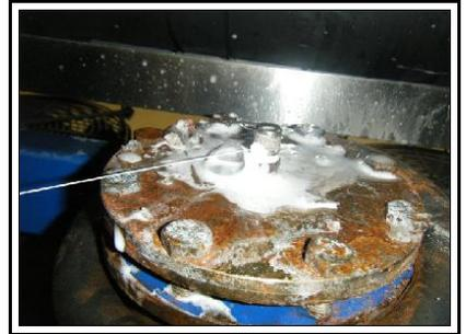
Fuite sur vanne à valve Schrader sur porte-filtre
