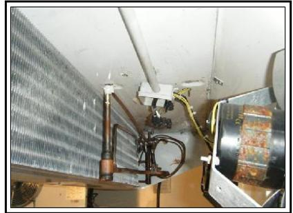
Piège à huile installé sur l'évaporateur
