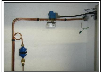
Vue du déshydrateur, voyant liquide et vanne électromagnétique
