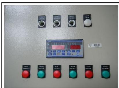
Centrale froid positif, façade armoire électrique
