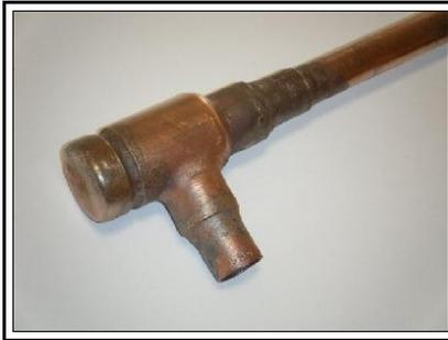
Piège à huile – les éléments assemblés
