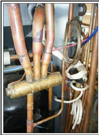
Vanne quatre-voies et détendeur
