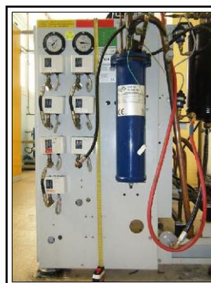
Centrale froid positif, éléments de régulation pressostatique
