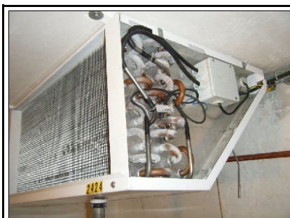
L'évaporateur de la chambre froide
