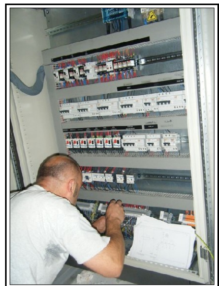
Branchement dans l'armoire électrique
