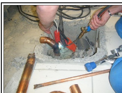
Lignes débouchant dans la zone de vente (futures vitrines froid négatif)
