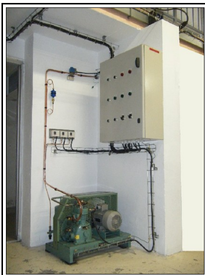
Installation froid positif monoposte, vue d'ensemble
