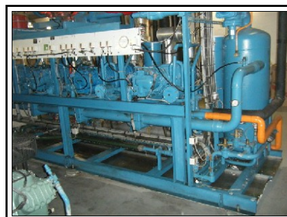
Centrale à compresseurs à vis pour froid positif via eau glycolée
