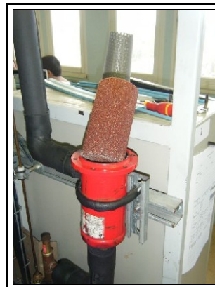
Cartouche-filtre en cours d'installation
