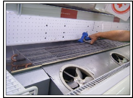
Enlèvement de la glace par jet d'eau chaude
