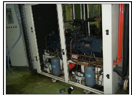
Centrale à deux compresseurs
