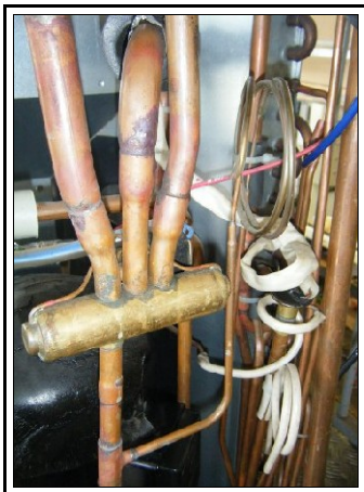
Vanne quatre-voies et détendeur
