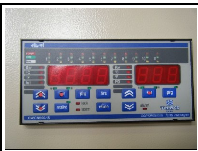
Centrale froid positif, automate Eliwell EWCM900/S
