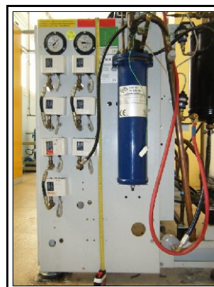
Centrale froid positif, éléments de régulation pressostatique
