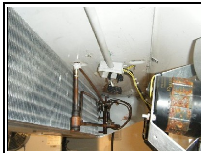
Piège à huile installé sur l'évaporateur
