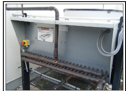
Interrupteur de sécurité posé sur le condenseur
