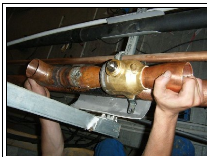
Vanne d'isolement ligne d'aspiration
