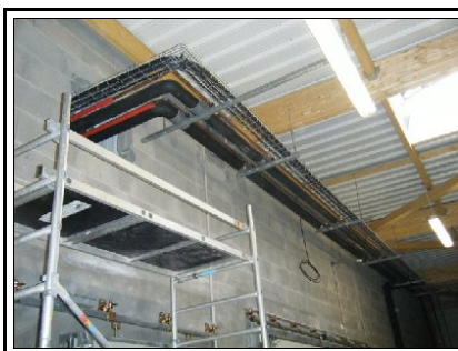
Nouvelles lignes d'aspiration et liquide (froid positif et négatif)
