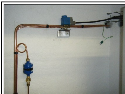
Vue du déshydrateur, voyant liquide et vanne électromagnétique
