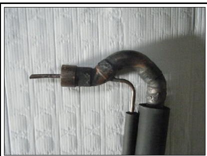
Double colonne sur ligne d'aspiration
