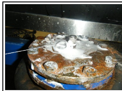
Fuite sur vanne à valve Schrader sur porte-filtre
