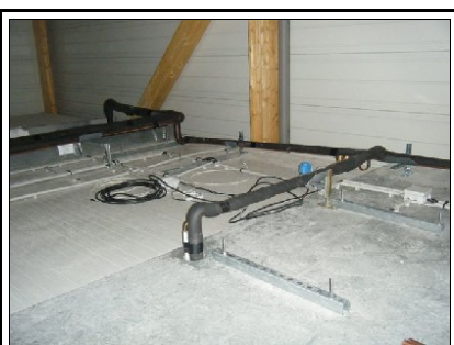
Ligne vers chambre froide positive
