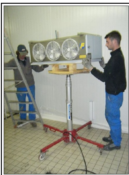
Démontage d'un évaporateur
