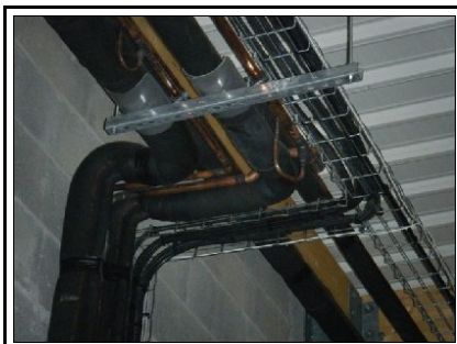
Nouvelles lignes d'aspiration et liquide (suite)
