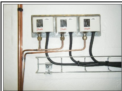
Vue des pressostats de régulation, sécurité BP et sécurité HP
