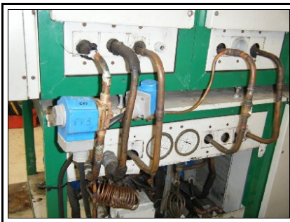
CTA – manomètres et électrovannes
