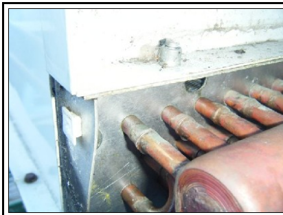
Fuite sur distributeur au condenseur
