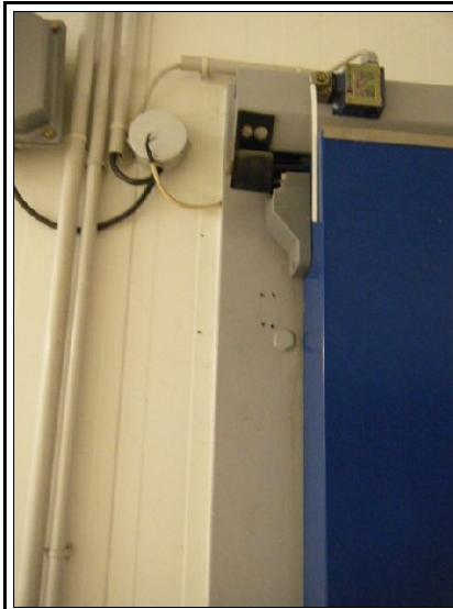
Connexion du cordon chauffant
