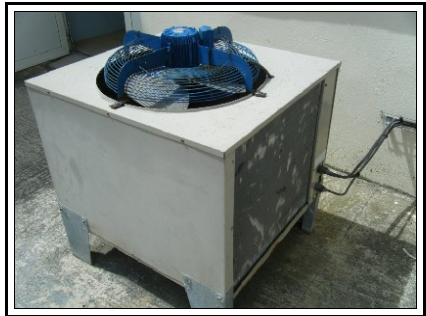
Airwell 1880 – condenseur à l'extérieur
