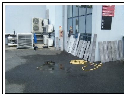
Filtres nettoyés en cours de séchage
