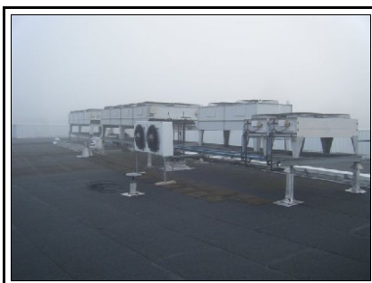
Montage d'un condenseur temporaire
