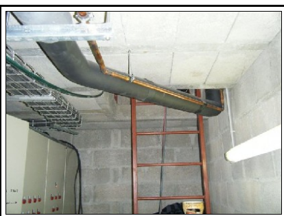
Nouvelles lignes d'aspiration et liquide (froid positif)
