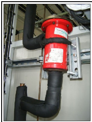
Porte filtre avant démontage
