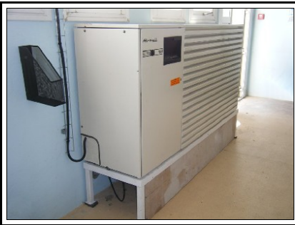
Armoire de climatisation de salle informatique Airwell 1880
