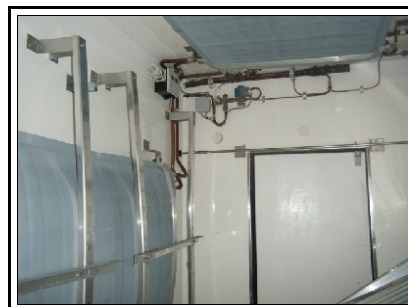
Plaque eutectique à remplacer
