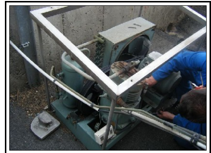
Desserrage de la fixation du moteur
